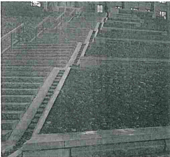
Figur 5. Exempel på dagvattenrännna längs med trappa.
