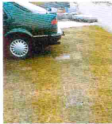
Parkeringsplats med gräsbeklädda pelleplattor
