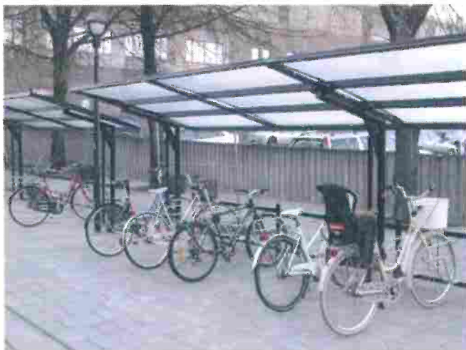
Figur 3-3 Exempel på en nyligen uppförd cykelparkering i Eskilstuna med väderskydd, belysning och ramlåsning. Källa: www.eskilstuna.se
