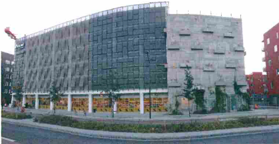
Figur 3-8 Parkeringshus i kv. Fullriggaren i Malmö där parkering har kombinerats med en matbutik i bottenvåningen. Källa: www.pmalmo.se
