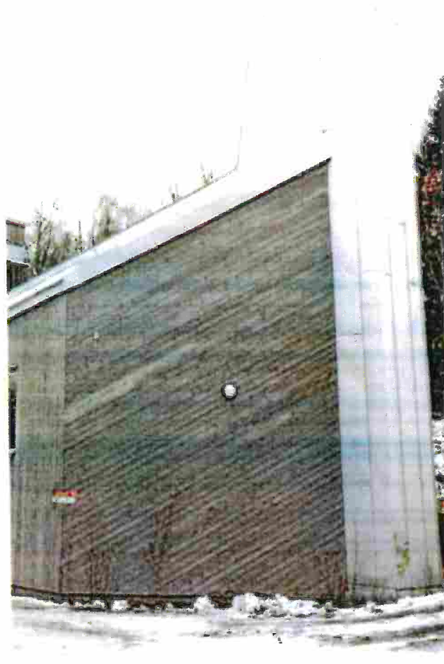
Detalj av fasad närmast skorstenen
