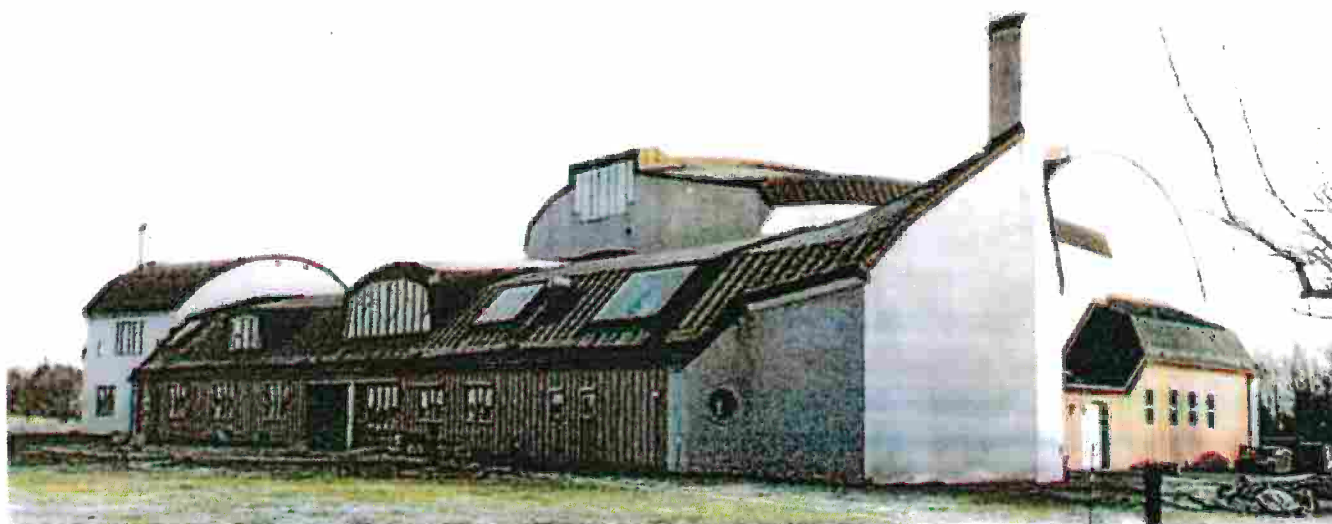
Vy mot västra sidan av kulturhuset med utblickar över fälten
