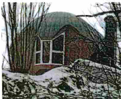
Burspråk mot söder
