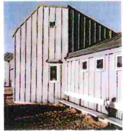
Volymmöte, fönster, vindskiva
