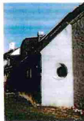
Fönster sydvästra gaveln
