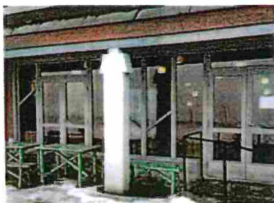
Pelare, fönster, dörrar i nisch på västra sidan
