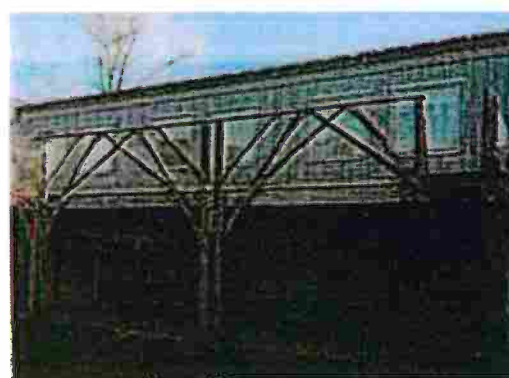
Läktare samt räcke
