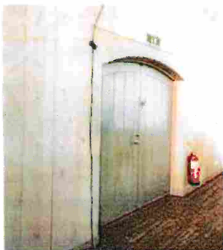
Dörrar, möte mellan vägg och golv
