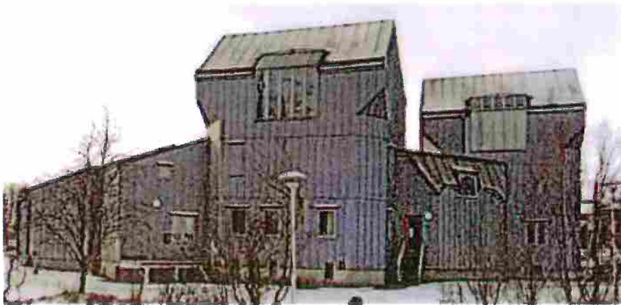
Robygge, vy från norr med fasaddetaljer, tak och fönster
