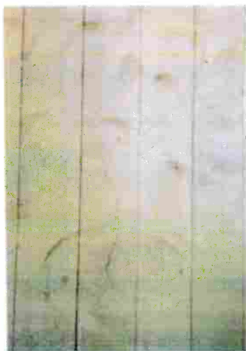
Detalj av väggar
