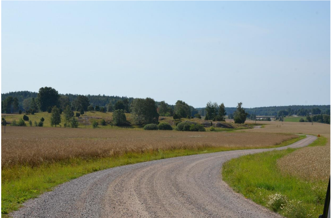
Figur 6 - Den ålderdomliga vägen mellan Åbro och Lundby.
