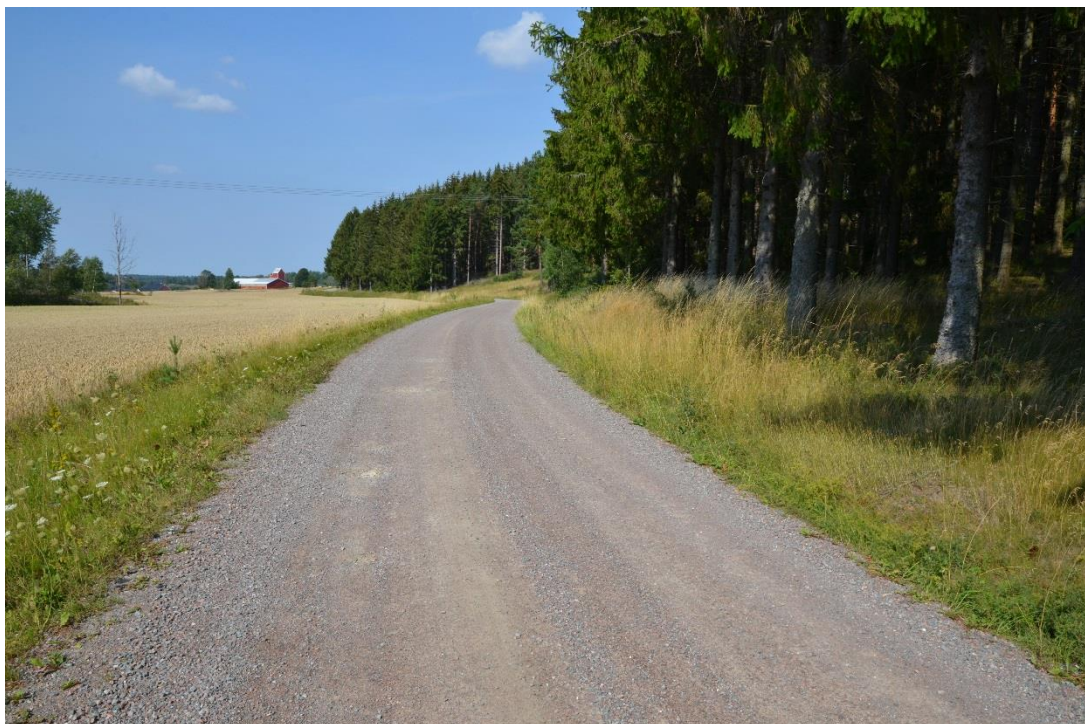
Figur 11 - Lundbyvägen i norra dalgångskanten. Ostlänken passerar på bro med brofäste i skogen till höger. I den övre vänstra kanten kan gården Lundby ses.
