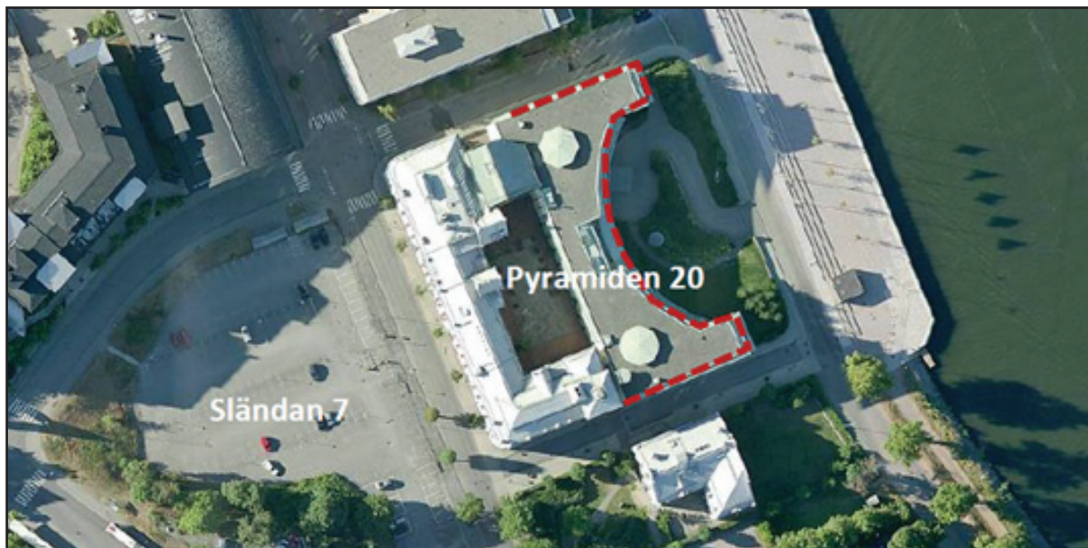
Bild: Fasad mot riskkällan (kanalen) och byggnadsdelar aktuella att förses med åtgärder avseende ventilation och utrymning.
