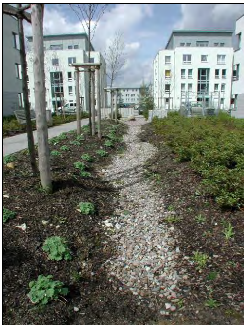
Figur 17. Exempel på stenlagt dike. Foto: Norconsult
