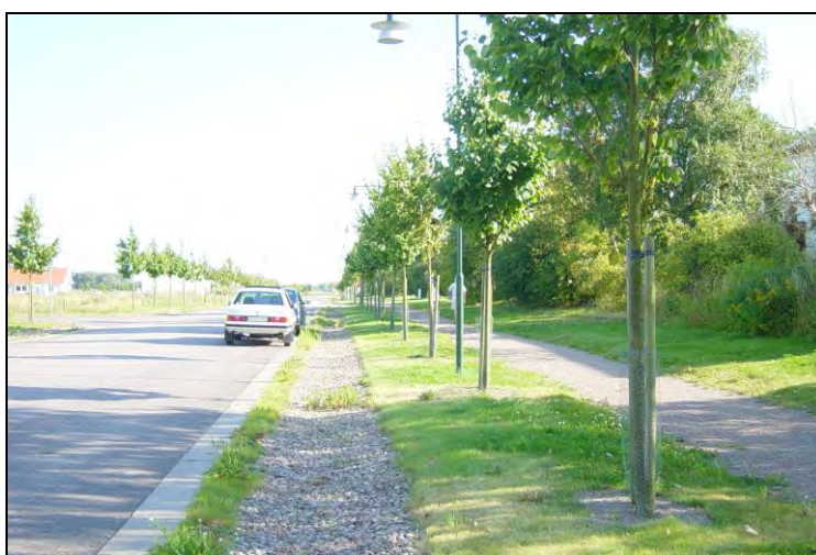
Figur 16. Exempel på makadamdike. Foto: Norconsult
