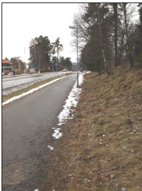
Figur 8. Gångbana längs Glasbergavägen i riktning västerut
