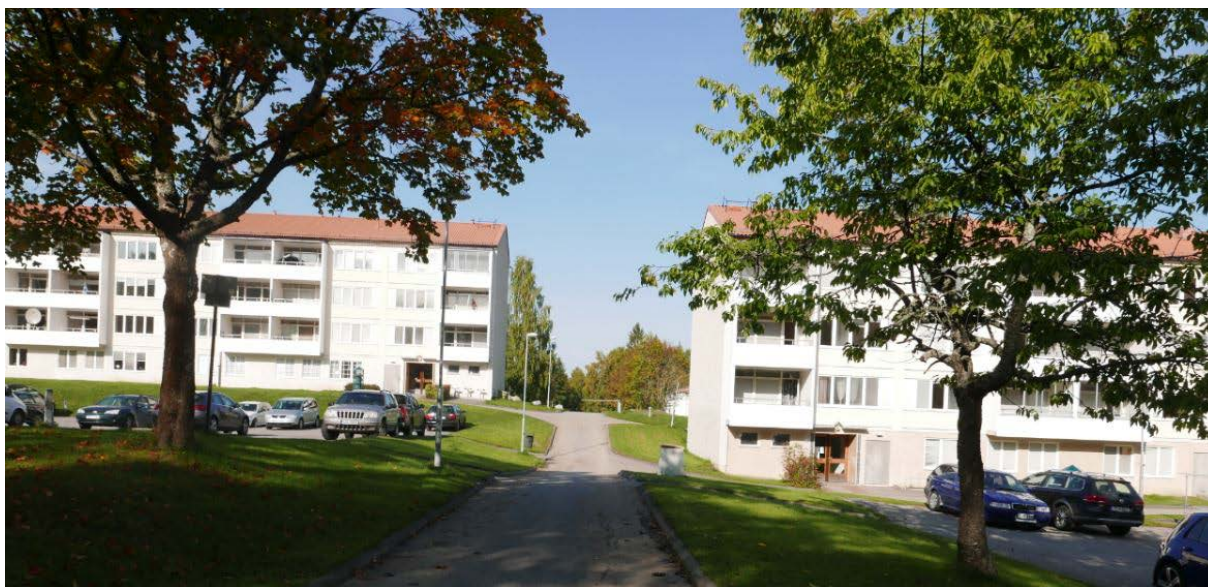
Genom området går en kommunal gång- och cykelväg i nord-sydlig samt öst-västlig riktning.
