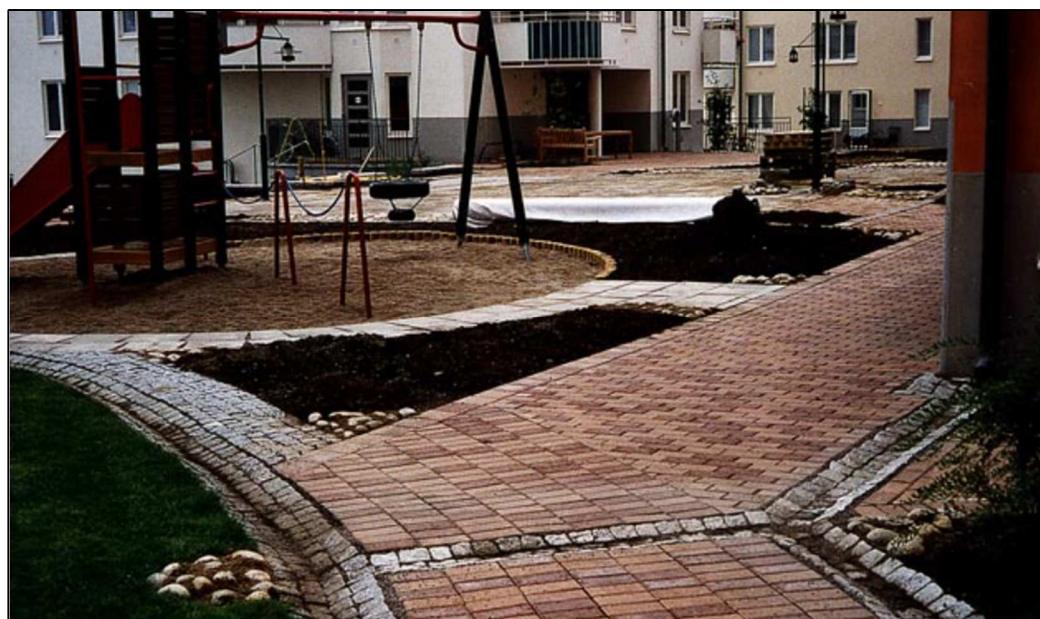
Figur 5-8. Exempel på avledning av takvattnet via rännalar anlagda med gatsten. Illustration från Stockholm Vatten.
