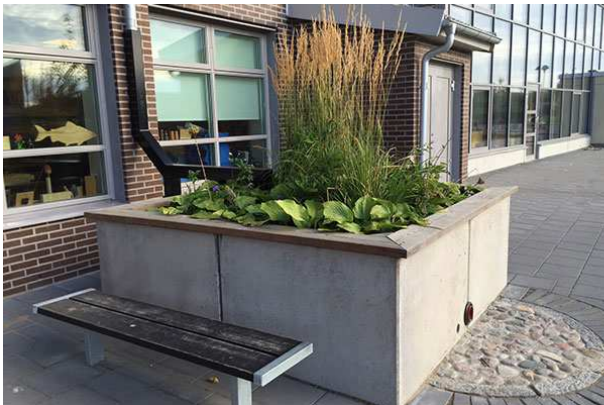
Figur 5-7. Exempel på hur växtbäddens utformning med vattenintag från utkastare. Illustration från Bara Mineraler och Hekla.
