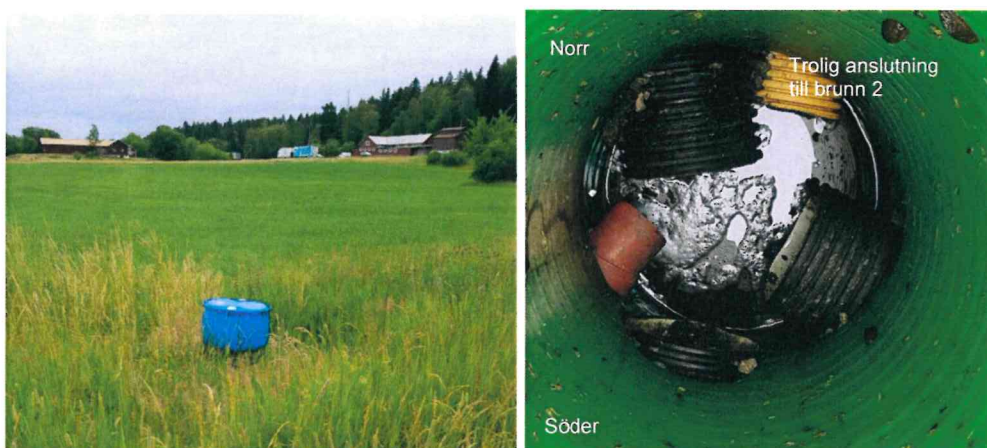
Figur 9. Brunn 1 fotad från öster (t v) och invändigt (t h). Gul ledning är belägen djupare än övriga och är troligtvis utloppsledning ansluten till brunn 2.
