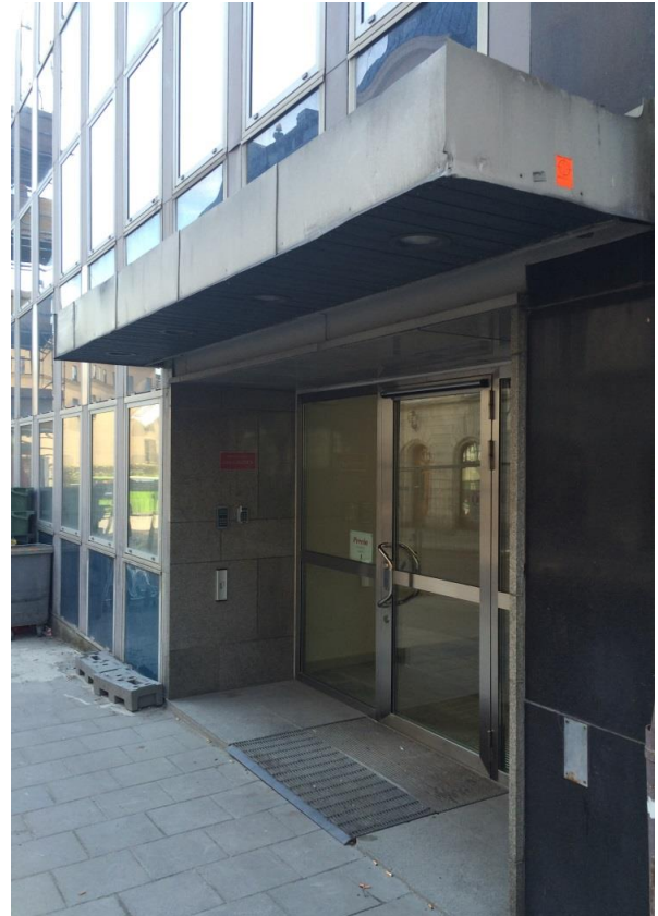
Entrépartiet är sidoförskjutet. Skärmtaket är inte centrerat utan sidoförskjutet. Den indragna entrén är klädd med polerad grå sten som i hörnet av huset möter den svarta stenen som inramar glasfasaden.
