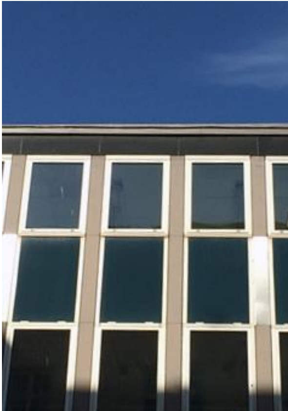
Glasfasad med blåa fönsterpartier, vertikala plåtklädda band mellan fönster och svart granit som inramar fasaden
