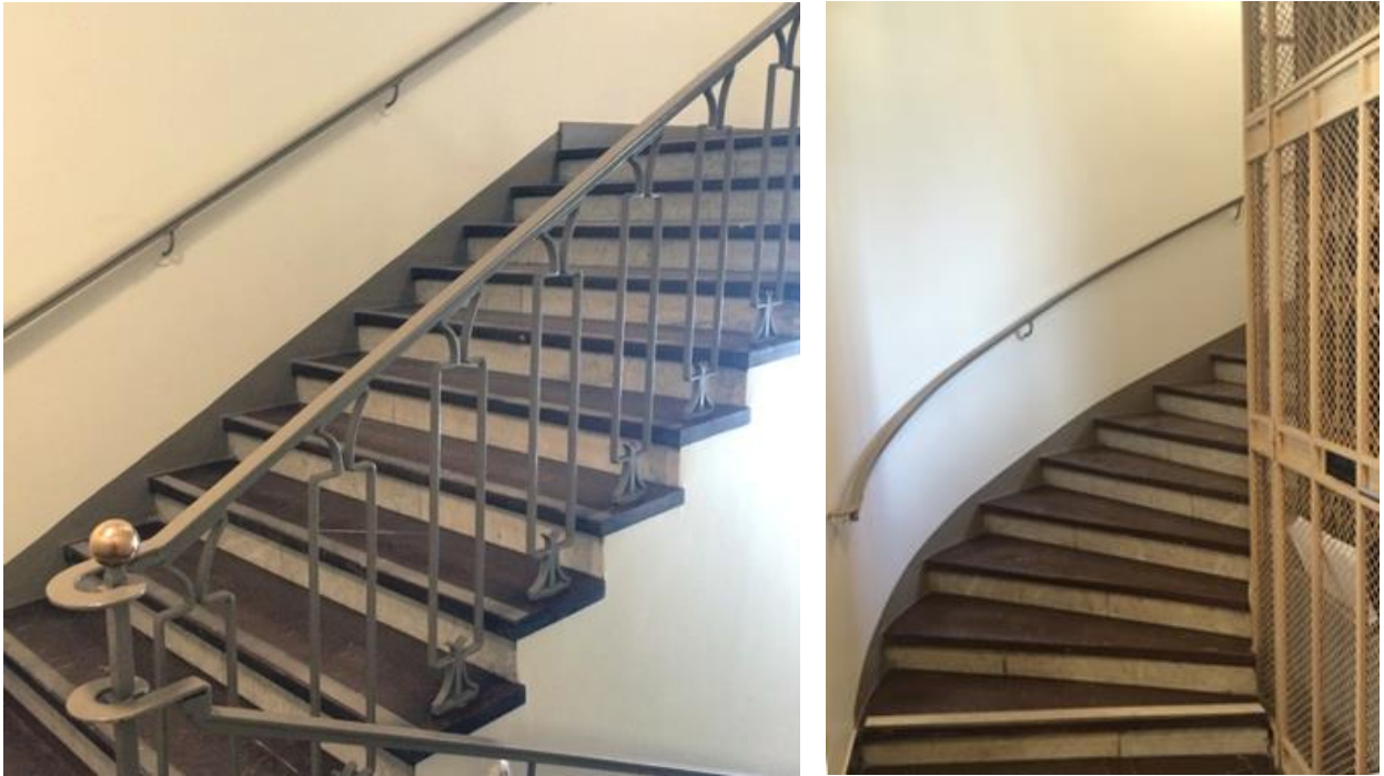
Trapphusets smidesräcke samt stenbeläggning
