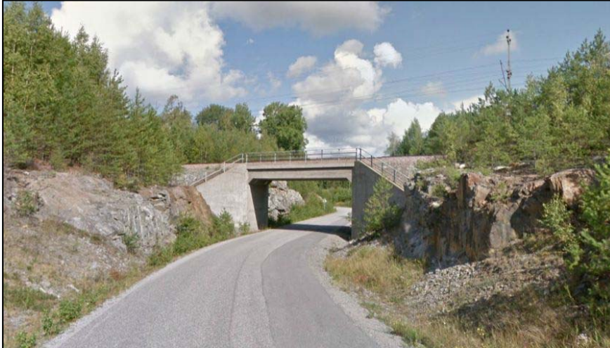
Figur 4 visar Svealandsbanan som passerar planfritt över vägen som går söderut från Almnäs. (bild från Google)
