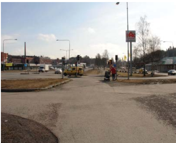
1) Befintlig korsning mellan område A och D
