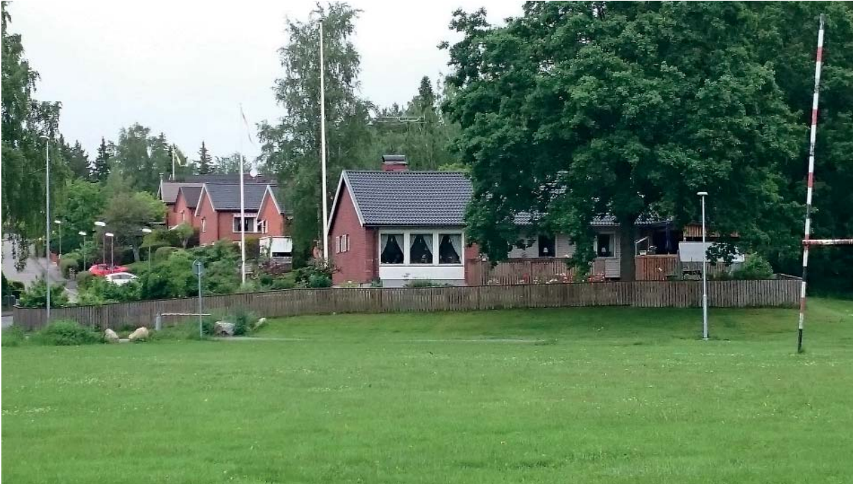
Befintlig bebyggelse norr om planområdet
