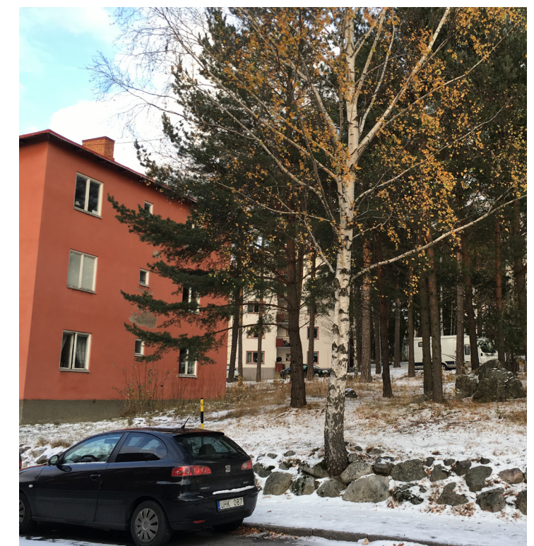
Mur mot Strindbergsvägen
