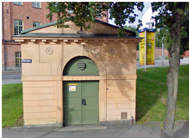
Foto: Transformatorstation i södra delen av planområdet.
