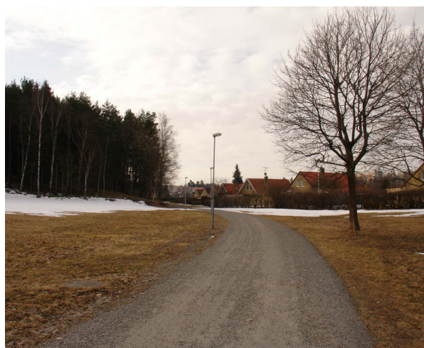
2) Gång- och cykelväg
