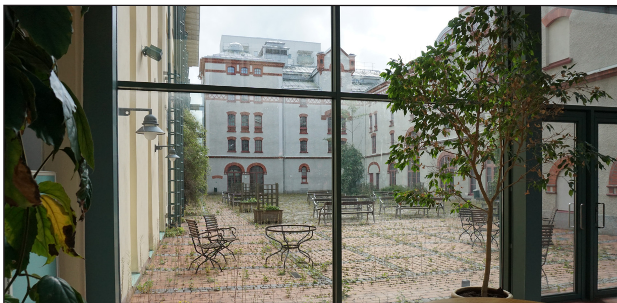
Bild: Gården mellan de två huskropparna är mönsterlagd med kalksten som ramar in av marktegel och gatsten.
