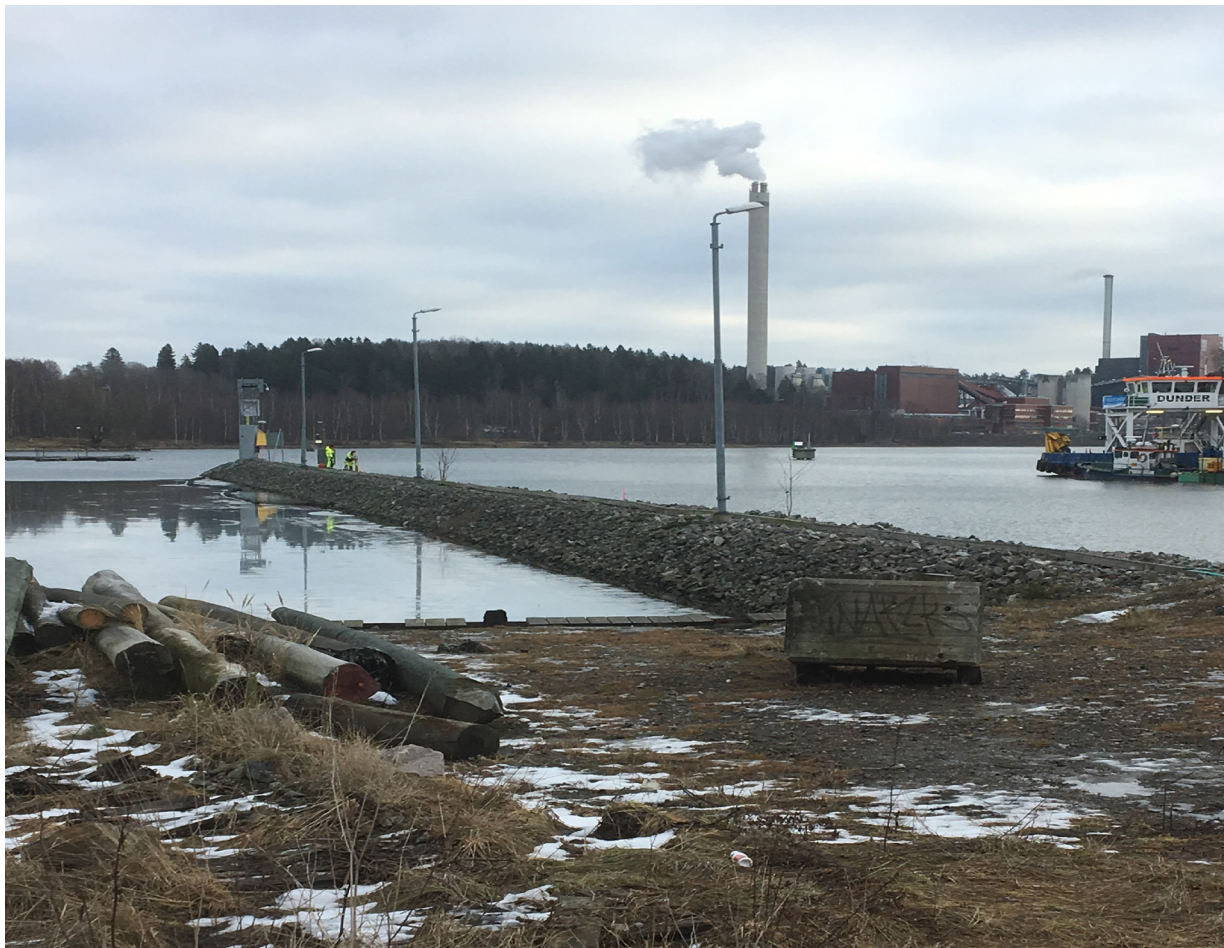
Befintlig stenpir 2017, bild ETTTELVA Arkitekter
