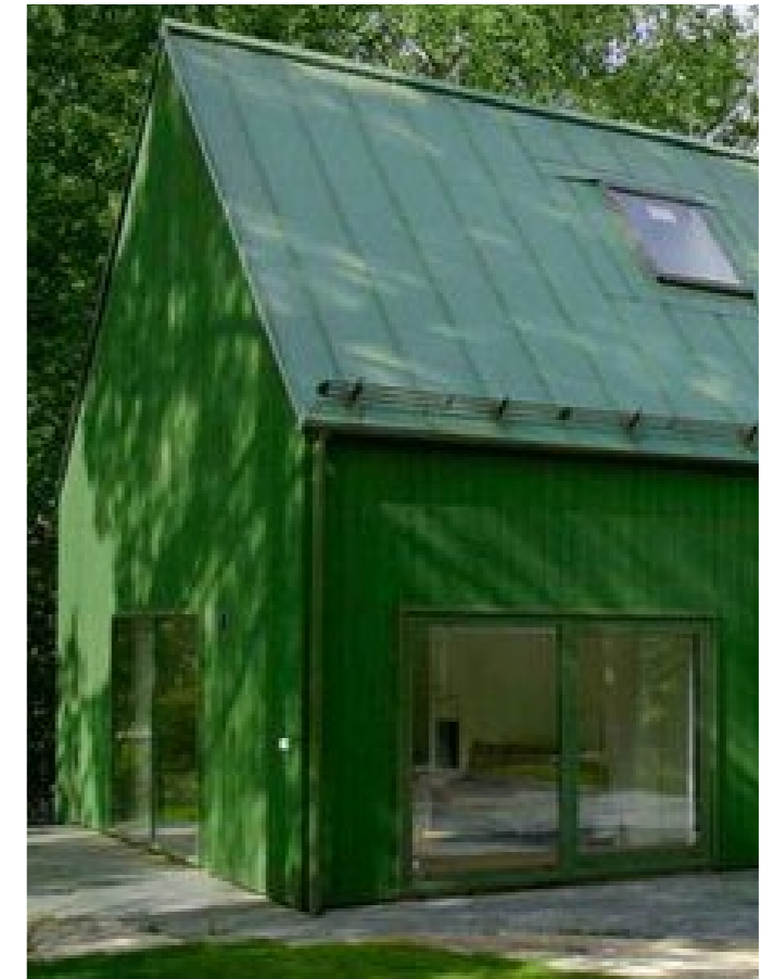
Den gröna träfasaden övergår i ett plåttak i samma kulör.
