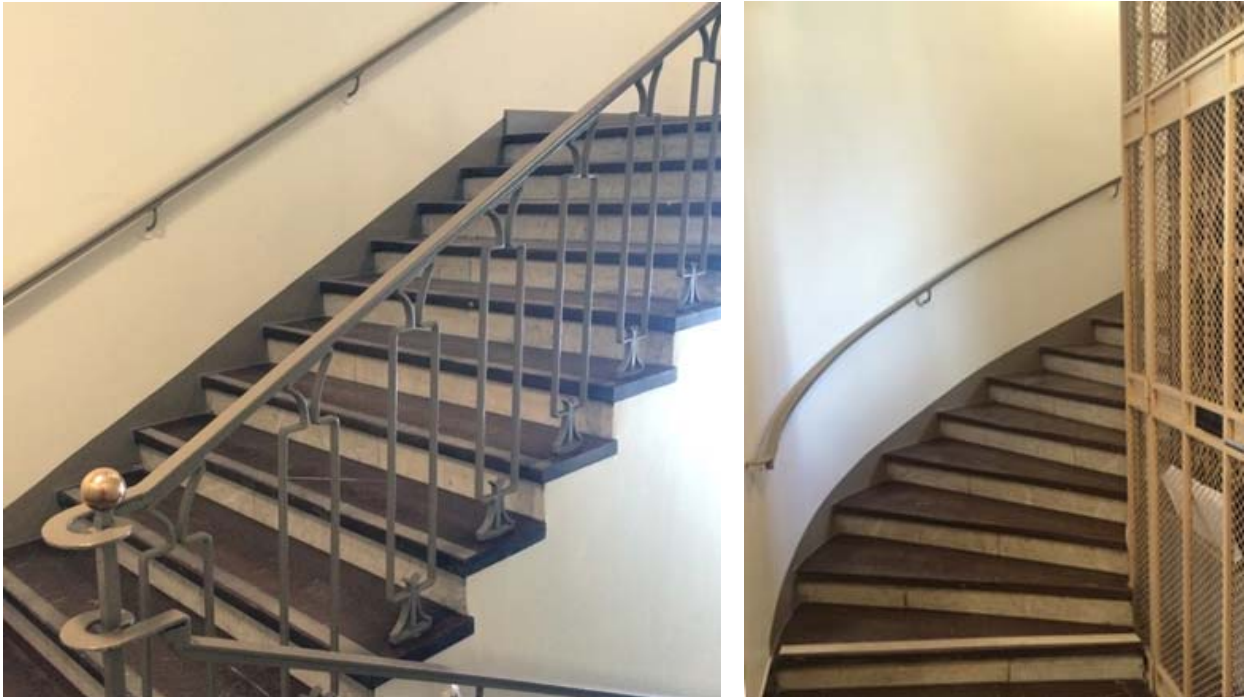
Trapphusets smidesräcke samt stenbeläggning
