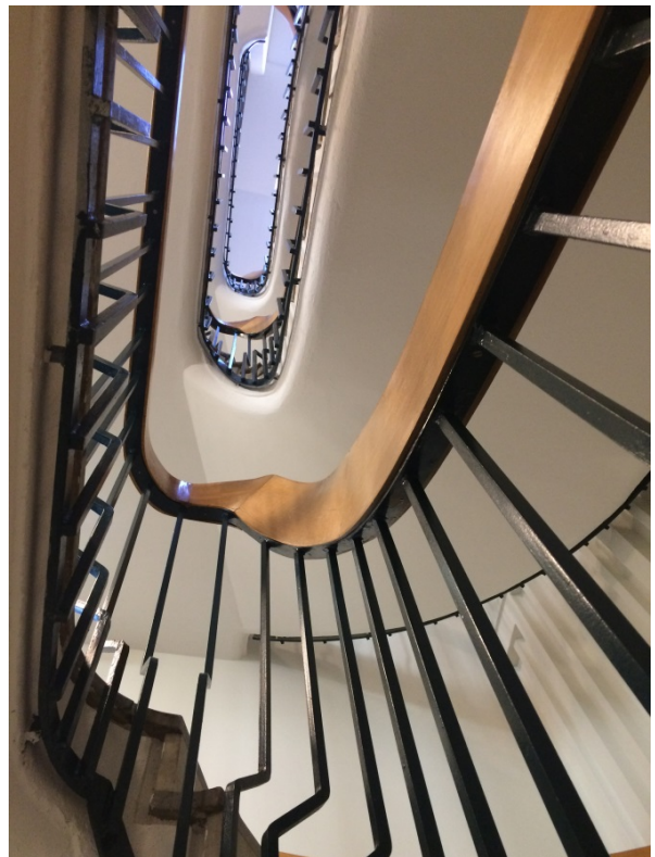
Trappan med smidesräcke med skarp vinkel nedtill och med handledare i lackat trä.
