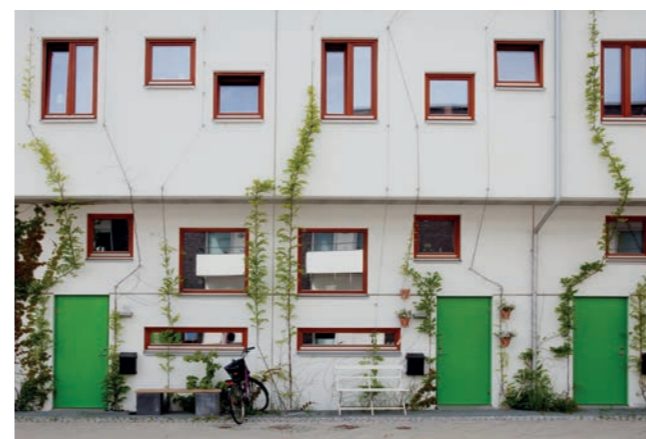
Exempel på hur bostadshus genom yttre möblering, materialval och växtlighet kan skapa fina möten med gaturummet. Cykelhuset Oh-boy! av Siegel + Hauschild Arkitekt.
