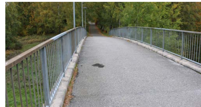
Gångbro som koppling mot Måsnaren i nordvästra Geneta
