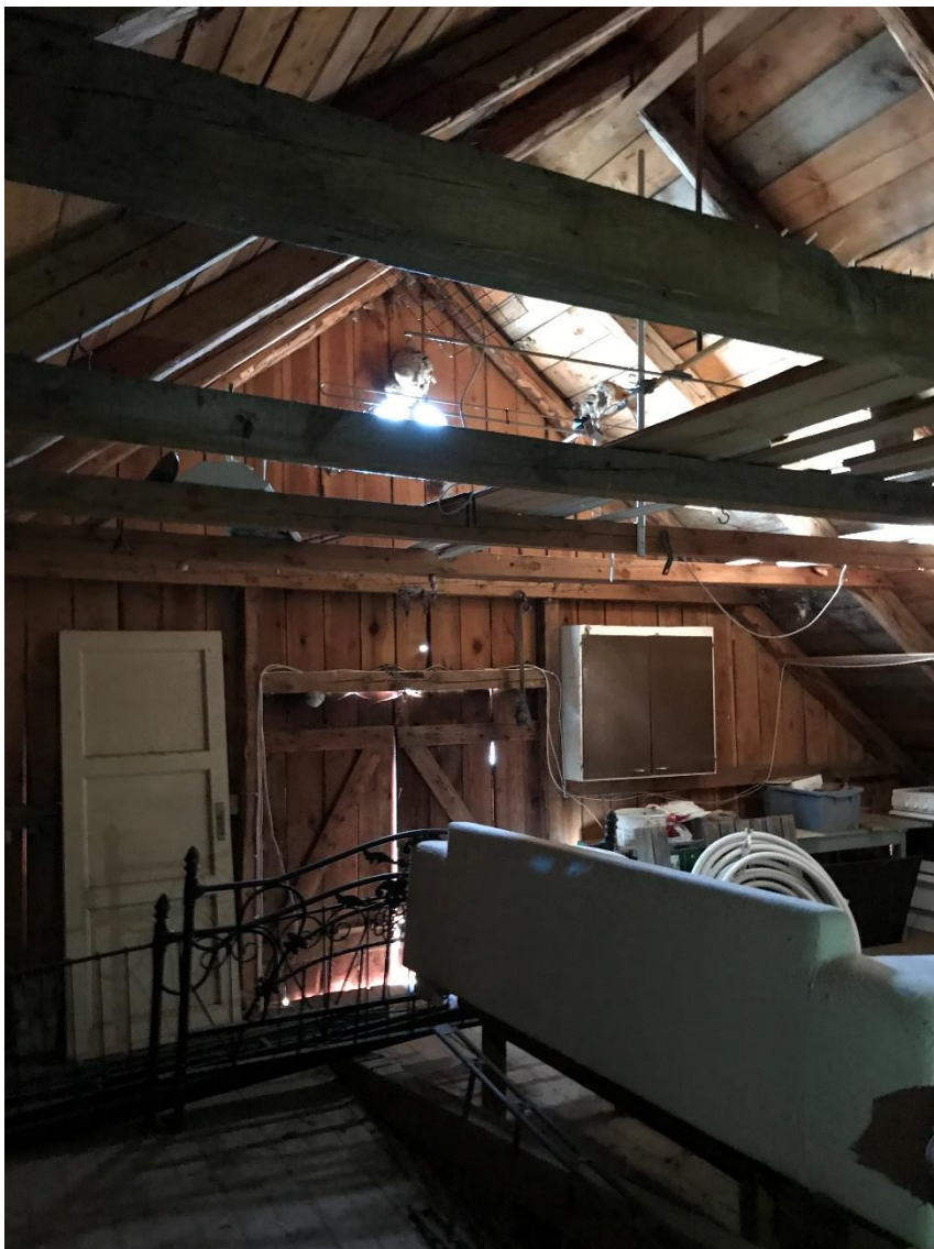
Vinden med luckor i gavelröstet mot väster. Ovanför skymtar lunettfönstret. En spännbock löper över vindsrummet för att skapa förutsättning för ett helt öppet rum i bottenvåningen, vilket enligt Wilunds utredning var knutet till produktionen.
