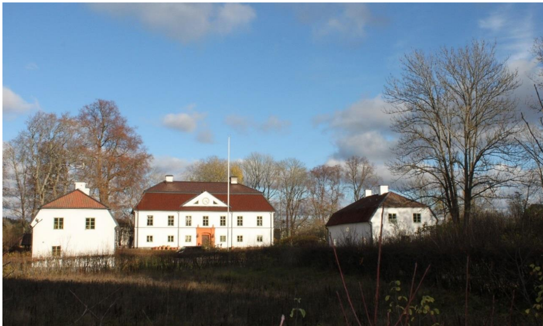
Glasbergas huvudbyggnad och parställda flyglar
