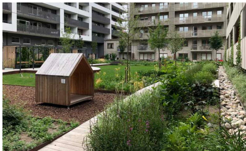
Exempel innergård, olika zoner och markbeläggning. Norra Djurgårdsstaden. Foto: Metod arkitekter
