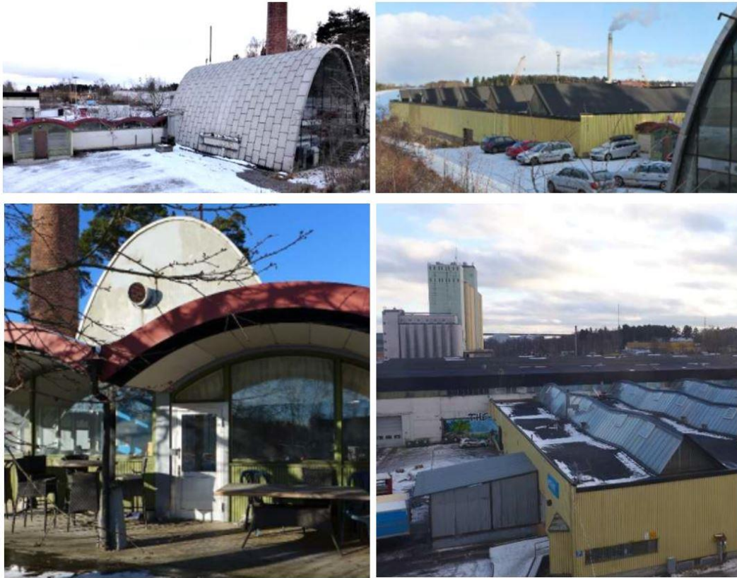
Figur 17. Den bågformade Panncentralen med förbindelsebyggnadens vågformade tak och hallbyggnaden i gult (AIX Arkitekter).
