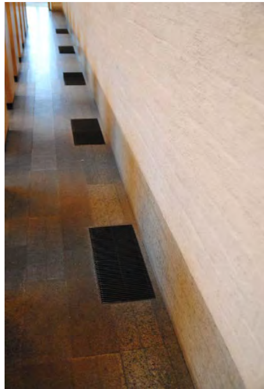
Kyrkorummets mönstermurning med dold ventilation, med snedställt murverk vid fönsteröppningar originalarmaturer samt kalkstensgolv med ventilationsgaller
