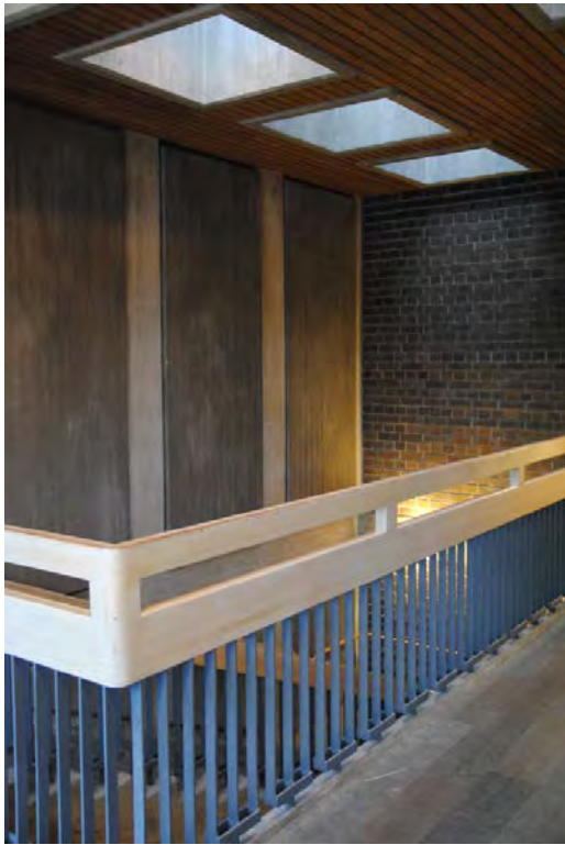
Trappan med lanterniner i tak
