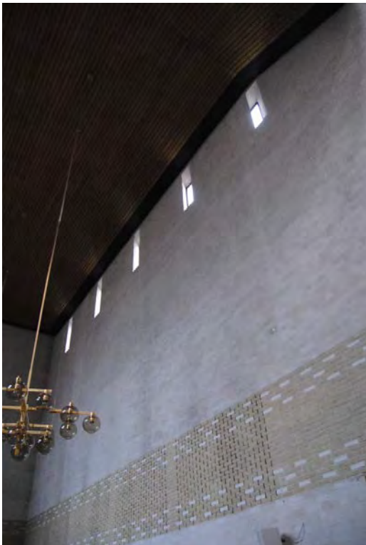
Kyrkorummets mönstermurning med dold ventilation, med snedställt murverk vid fönsteröppningar originalarmaturer samt kalkstensgolv med ventilationsgaller
