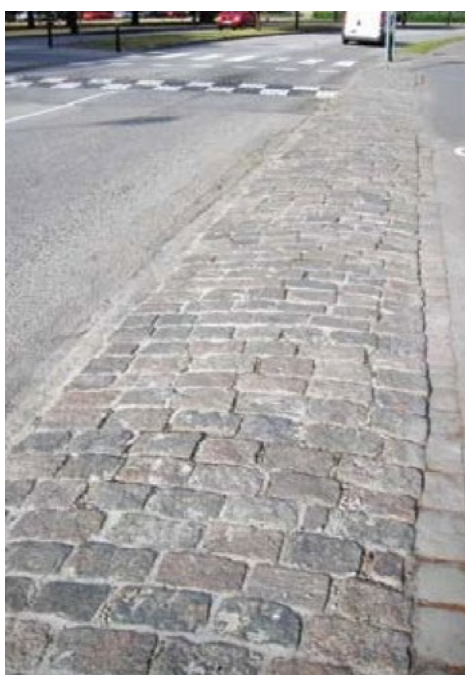
Bild 38. Ytor ett år efter åtgärd med krossad betong och fogsand.
