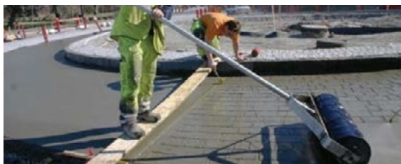
Bild 1. Platsgjuten betong i cirkulationsplats i Malmö.
