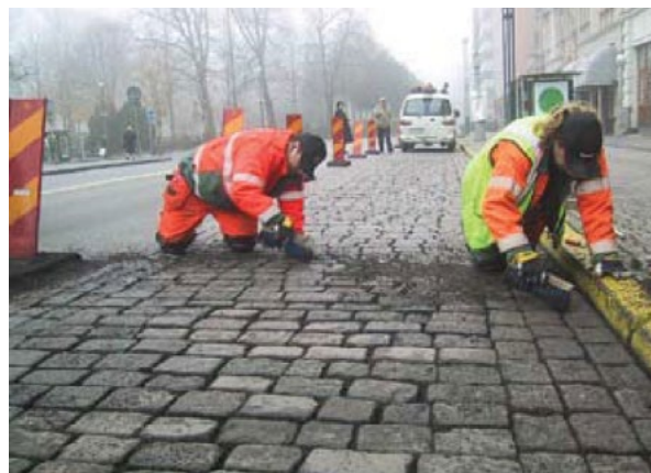
Bild 22. Rengöring av fogar.
