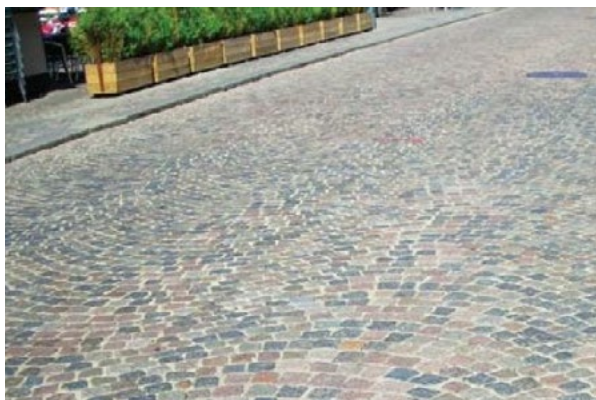
Bild 13. Epoxifogar i Gammeltorv/Nytorv, Köpenhamn.
