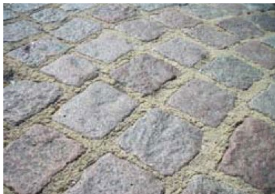
Bild 14. Epoxifogar i Gammeltorv/Nytorv, Köpenhamn.
