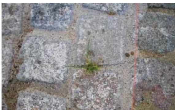
Bild 5. För smal fog vilket har resulterat i ogräsuppslag i otrafikerad yta.
