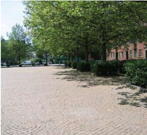
Bild 26. Smågatsten på S:t Knuts torg fogade med traditionell fogsand.
