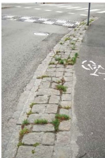
Bild 39. Ytor ett år efter åtgärd med krossad betong och fogsand samt cirka 7 % tillsats av lera.
