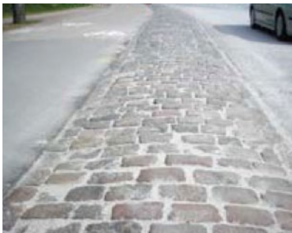
Bild 34. Ytor direkt efter försegling med betongkross och fogsand.
