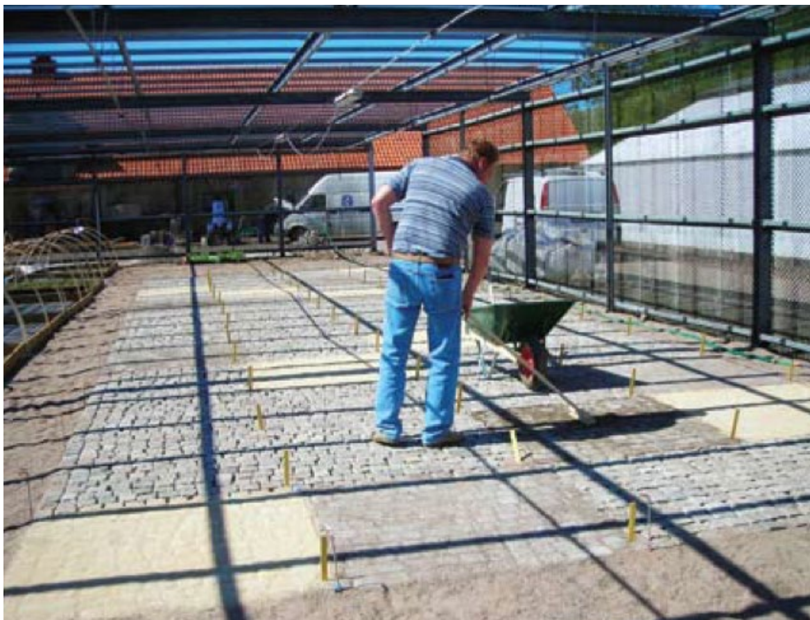
Bild 41. Anläggande av testyta i Alnarp.
