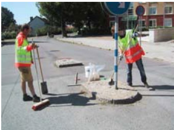
Bild 31. Utläggning av fogmaterial med olja/polymerer.
