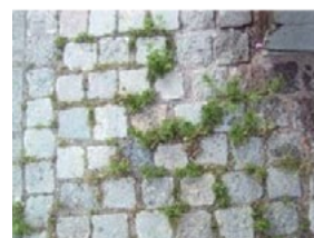
Bild 11. Yta som inte slits och täcks med ogräs.
