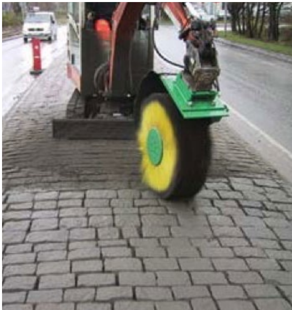
Bild 12. Test av specialborste för rengöring av fogar.
