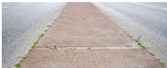
Bild 2. Platsgjuten betong på mittremsa i Malmö.
