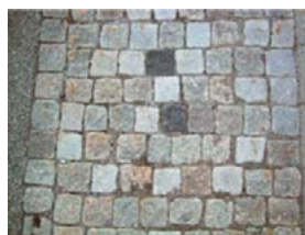
Bild 10. Yta som slits och som håller undan ogräs.
